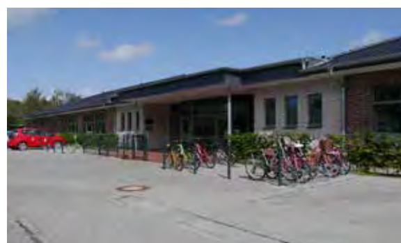
Abb. 131 und 132: Kindertagesstätte vor und nach der Sanierung
