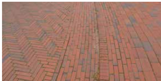
Abb. 85 und 86: Die Dorfstraße in einheitlich rotem Klinker mit wenig auffälligen und abgerundeten Bordsteinkanten
