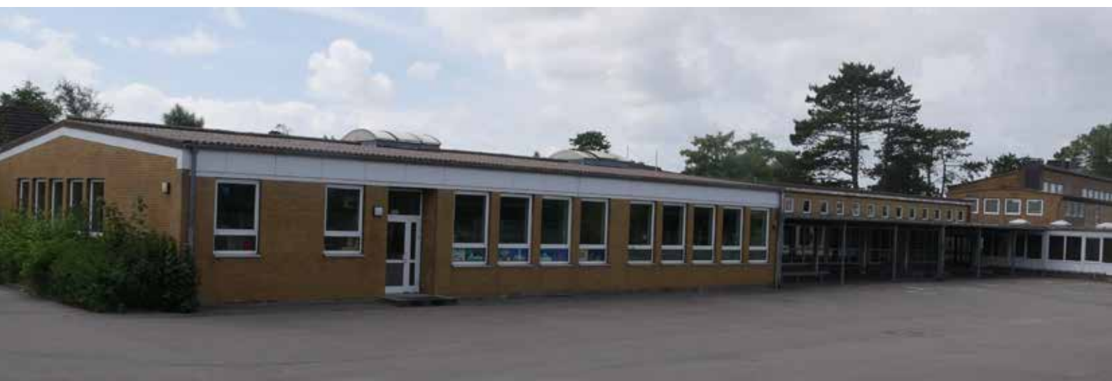
Abb. 169: Gemeinschaftsschulteil der Nordseeschule mit gestalterischen und funktionalen Defiziten
