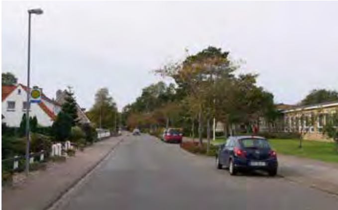
Abb. 38: Fasanenweg mit Gestaltungs- und Sicherheitsdefiziten
