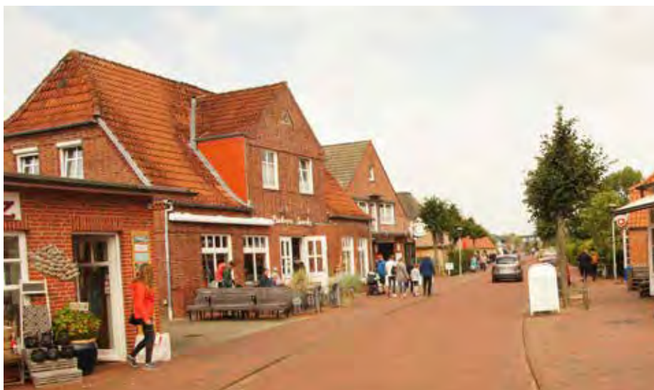
Abb. 168: Herausstehende Gullideckel auf dem Gehweg stellen Stolperfallen in St. Peter-Dorf dar (hier: Pestalozzistraße)
